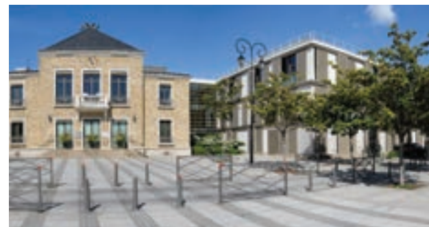
La société Citylone permettra à la ville des Mureaux d'optimiser les capacités de son éclairage.
